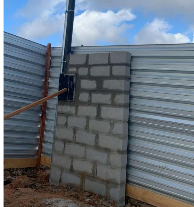
Foto 16: Execução do padrão de energia.
