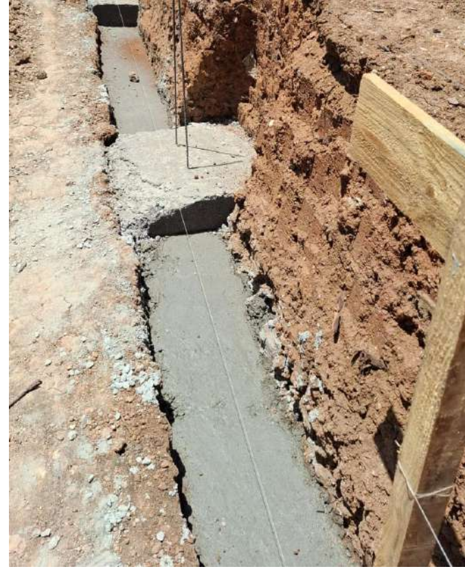
Foto 10: Execução da fundação do muro de contenção.
