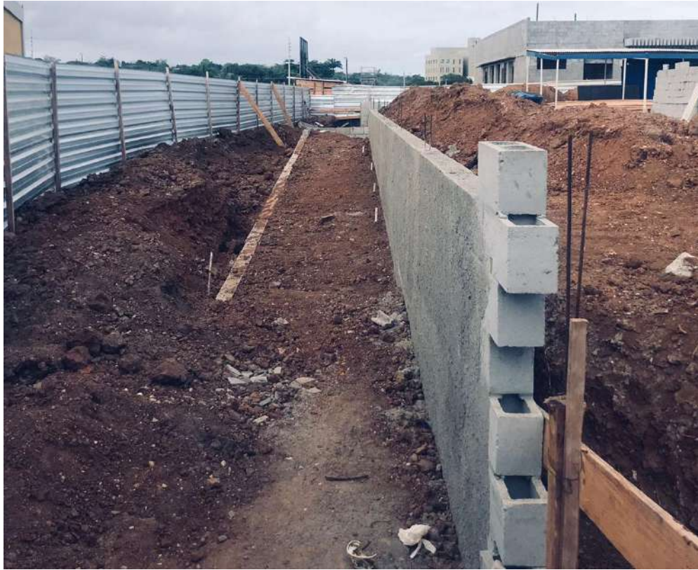
Foto 15: Execução do muro de contenção.
