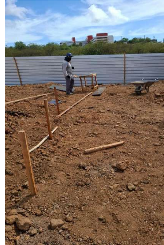
Foto 04: Início da execução do gabarito.
