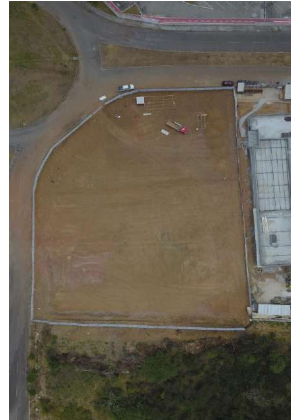
Foto 08: Visão aérea com fechamento completo da obra.
