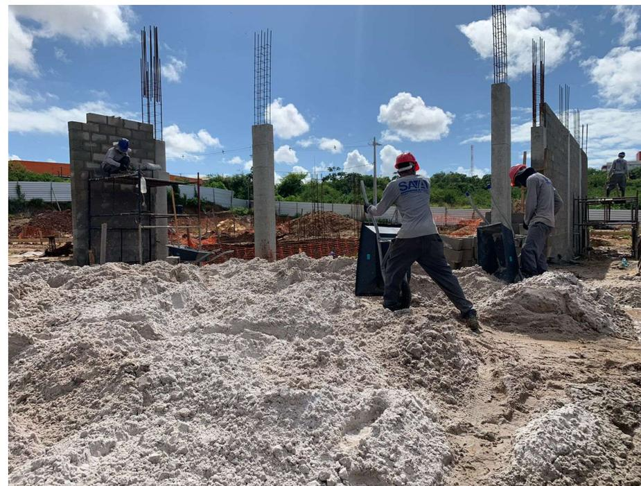
Foto 06: Transporte de areia para área do aumento do nível após compatibilização
