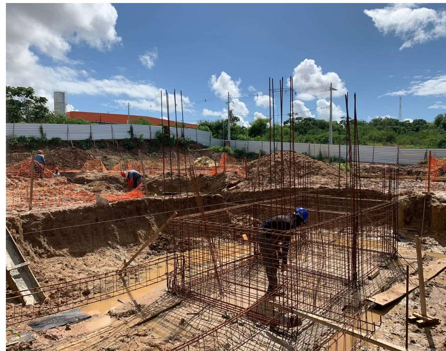
Foto 08: Armação das ferragens do poço do elevador
